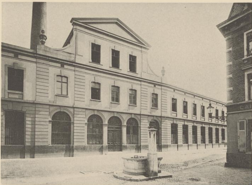
Hauptbau der Färberei. Mittelbau Rappoltshof. 1903.
