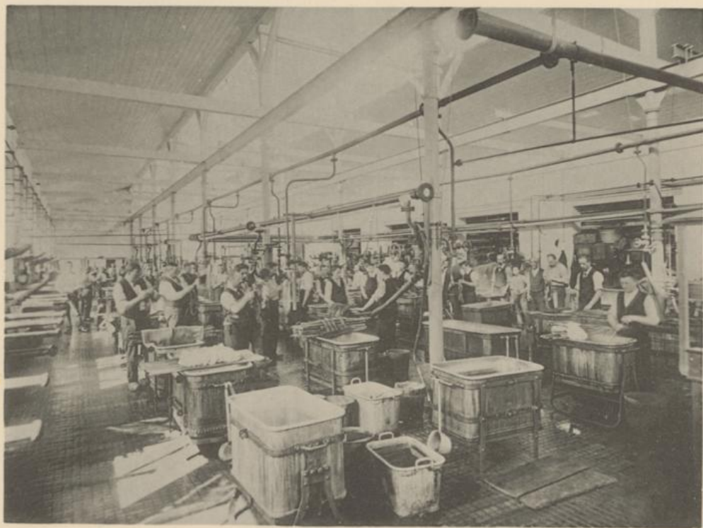
Im äussern Geschäft. Interieur der Färberei 1903. Neubau 1902.
