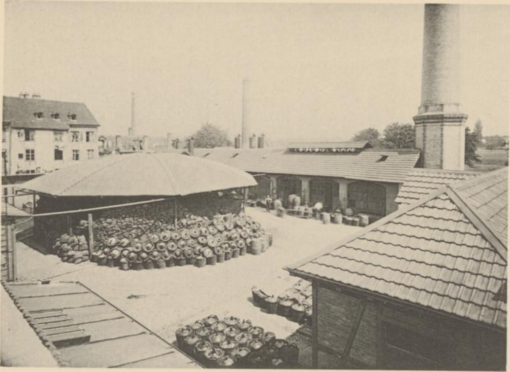
Im äussern Geschäft. Chem. Fabrik und Schopf. 1903.
