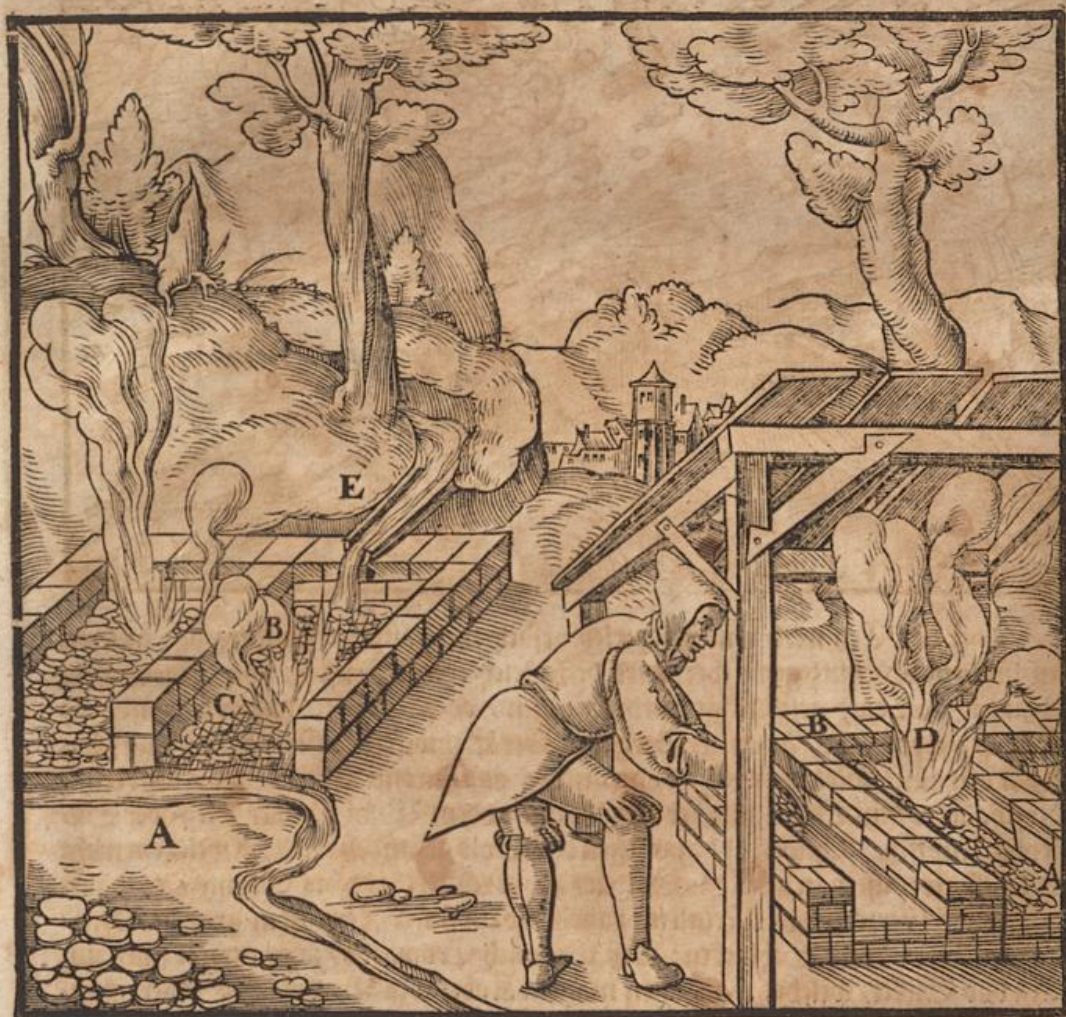
Herd A. Holz B. Das Erz C. Die gestalt des zils D. Die Rinne E.
