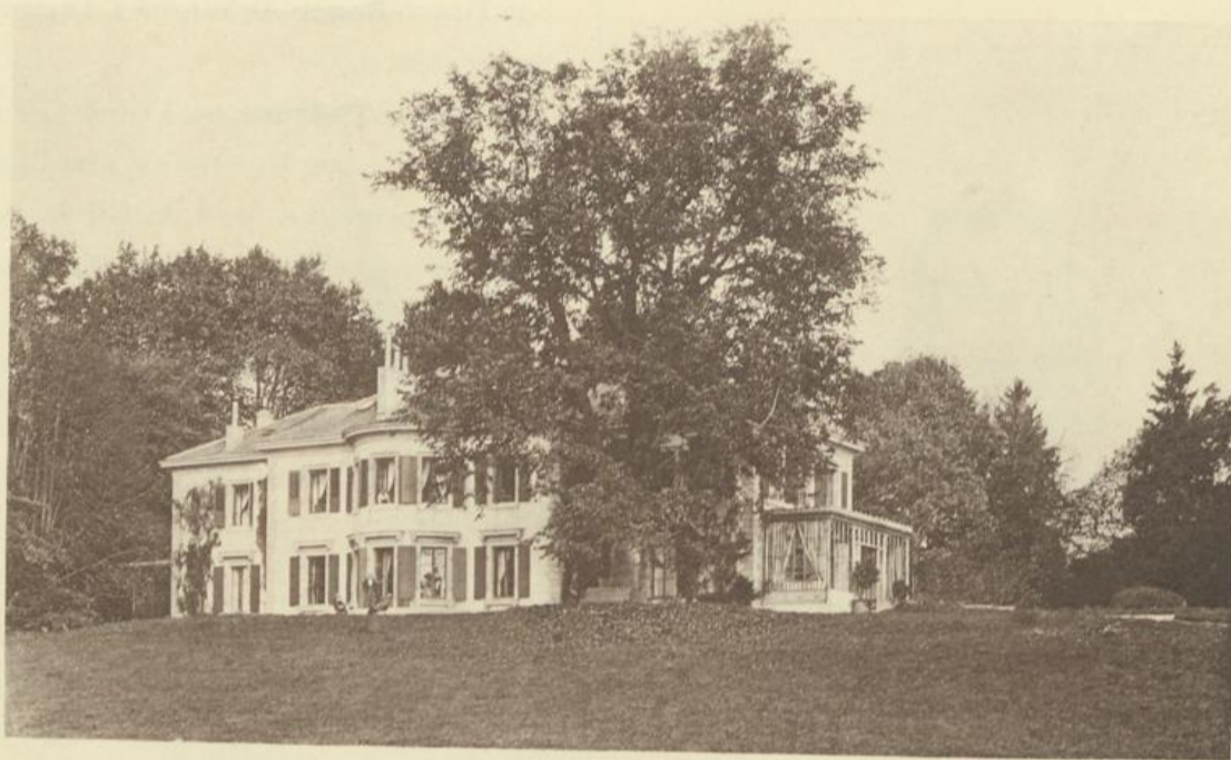
Lavigny — côté sud — 1902
