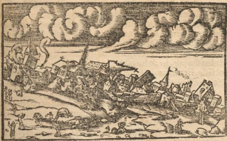
Terremoto horrendo in Costantinopoli.
