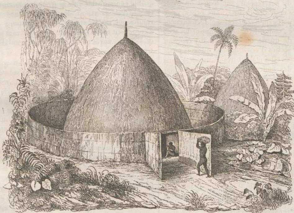
4. Habitations de la Nouvelle-Calédonie.
