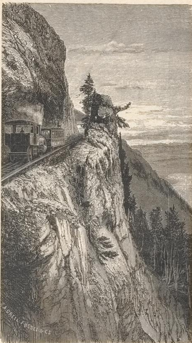
Fig. 36. — Kräbelwand. (Linea Goldau-Righi).
