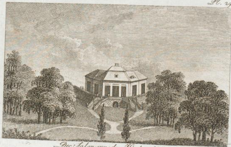
Der Salon von der Hinterseite.
